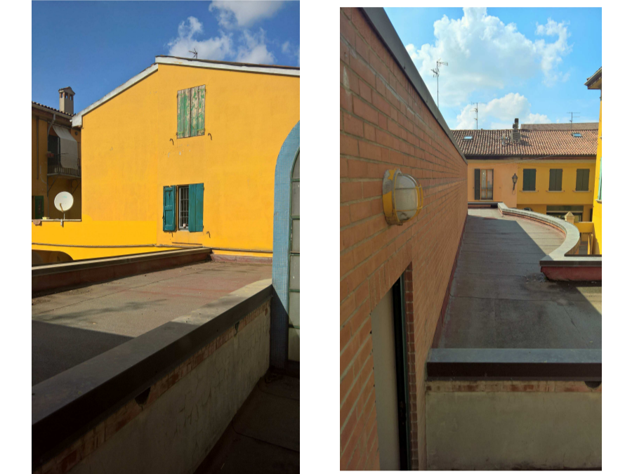
Copertura atrio centrale
